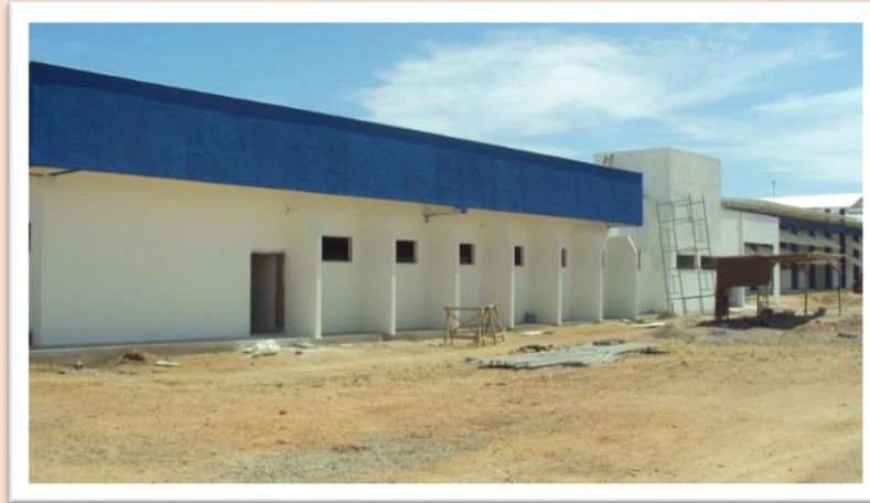
Foto 21: Construção do Campus 2013.
