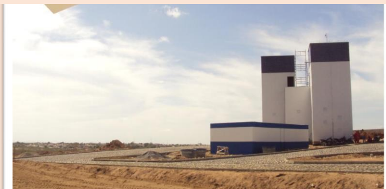
Foto 20: Construção do Campus 2013.
