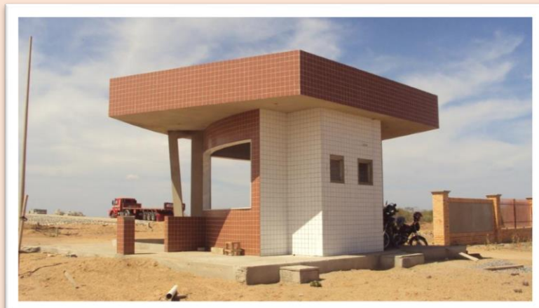
Foto 19: Construção do Campus 2013.
