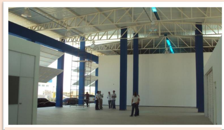
Foto 22: Construção do Campus 2013.
