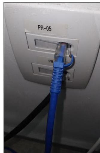
Figura 5 - Cabo NÃO conectado corretamente
