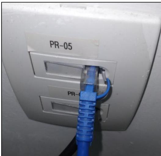
Figura 4 - Cabo conectado corretamente
